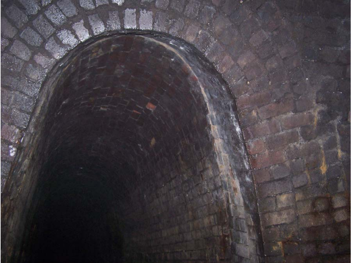
The top of the adit.
